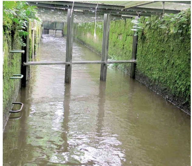
Aspecto del canal de Ximonde (río Ulla) tras su acondicionamiento
